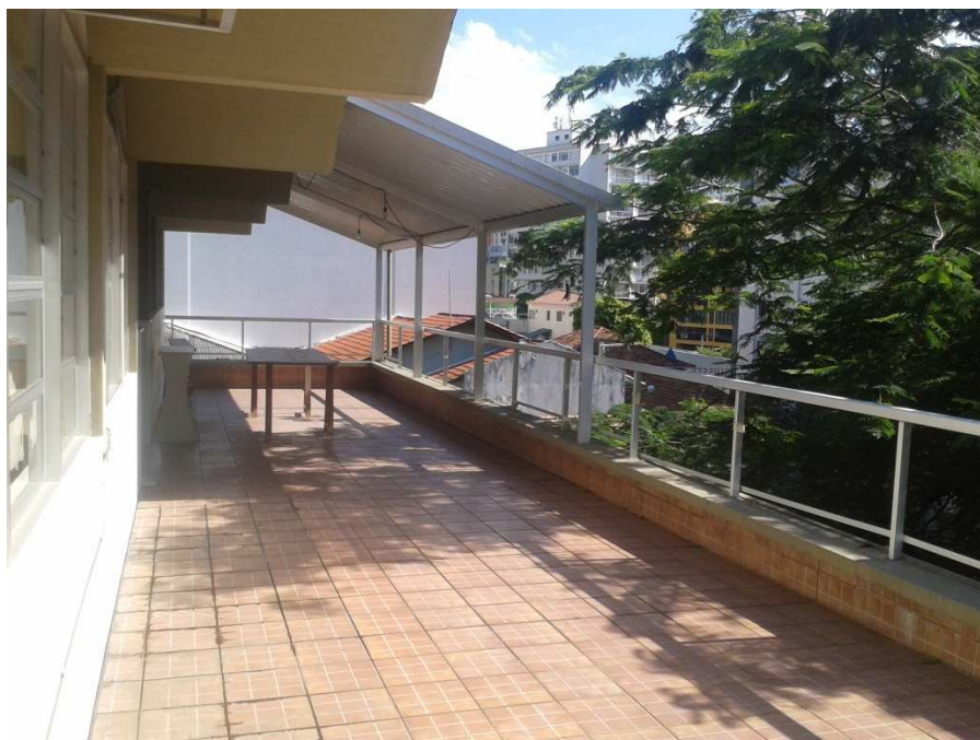
Figura 2 – Guarda corpo em alumínio sem vidros. Pingadeiras em concreto.
