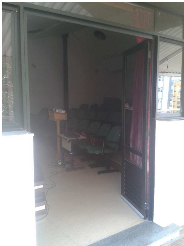
Figura 5 – Porta de acesso à área de apoio externa
