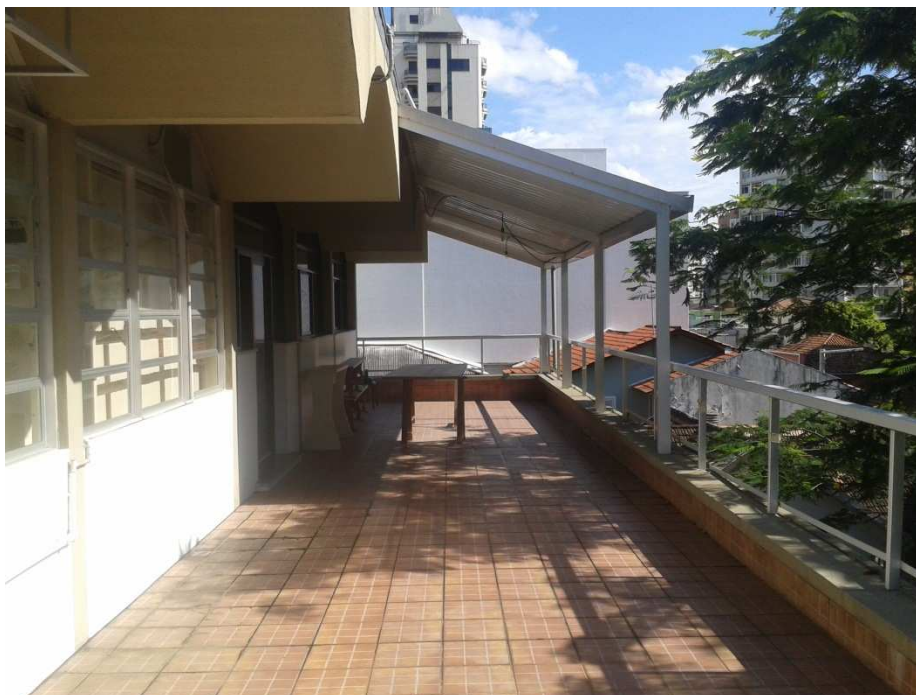
Figura 1 – Cobertura metálica existente
